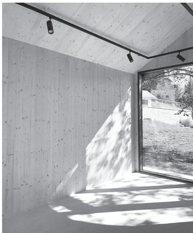
Prenovljena notranjost kozolca. Foto: Nadja Krašovec
