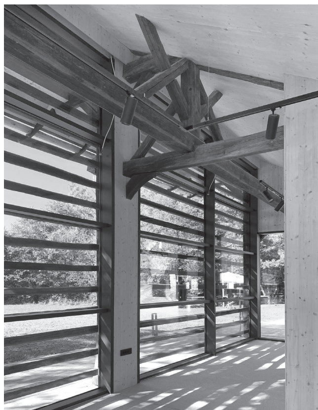
Prenovljena notranjost kozolca. Foto: Nadja Krašovec
